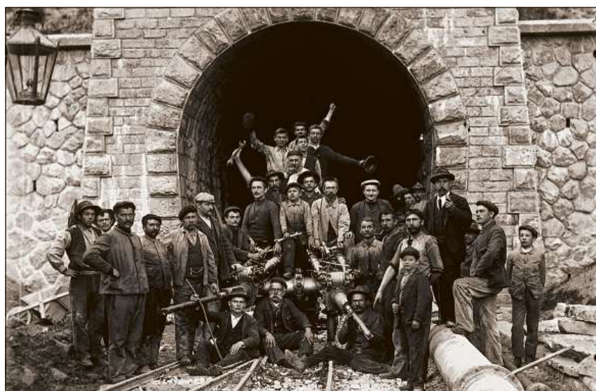
Erecziun dal tunnel da viafier da l'Alvra ch'è vegni avert il 1903.
