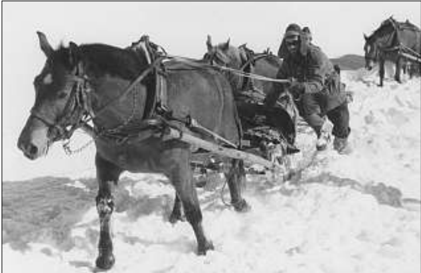
Ils schlusigls da la schlitta, che vegn duvrada per trassar la senda rutnada, èn liads a travers cun ina chadaina.
