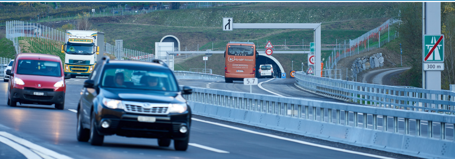
Foto: Umfahrung A13 Roveredo, Südportal
