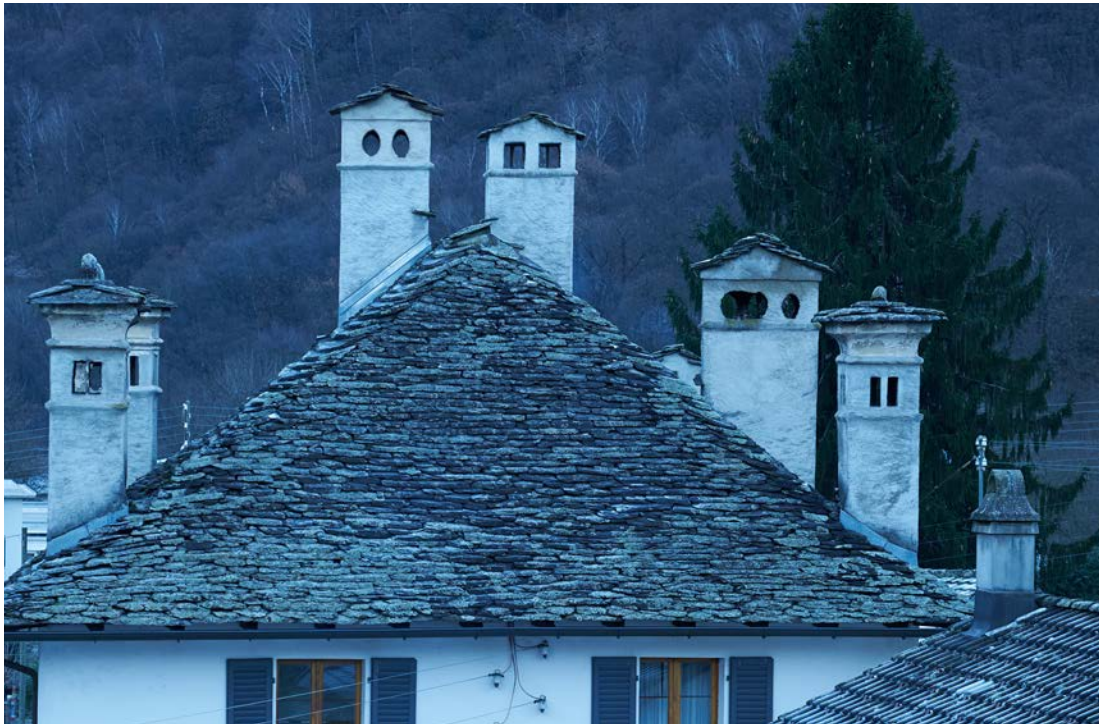
Il fumo prodotto dai riscaldamenti a legna inquina l'aria della Bassa Mesolcina. Nei prossimi anni i riscaldamenti a legna vecchi e inefficienti dovranno essere risanati o sostituiti. Foto: casa con diversi comignoli a Roveredo.
