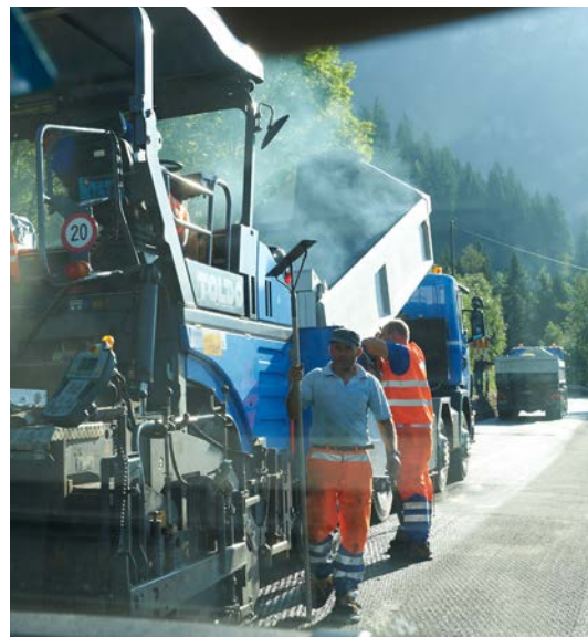
Per chi lavora sulle strade, un ulteriore problema è sovente rappresentato alla calura associata all'elevato inquinamento da ozono. Foto: cantiere stradale nel Cantone dei Grigioni.
