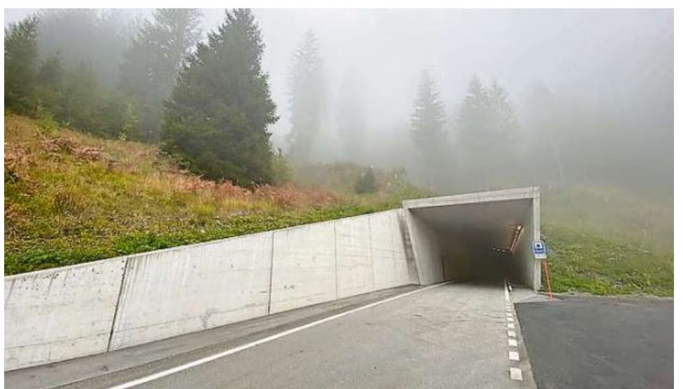
L'entrada dil nov tunnel «Plattas» che ha ina lunghezza da 440 meters.
