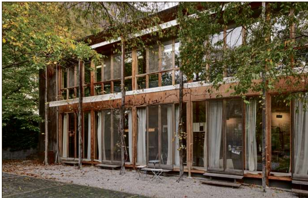
FOTO R. FEINER/52BESTEBAUTEN.CH
