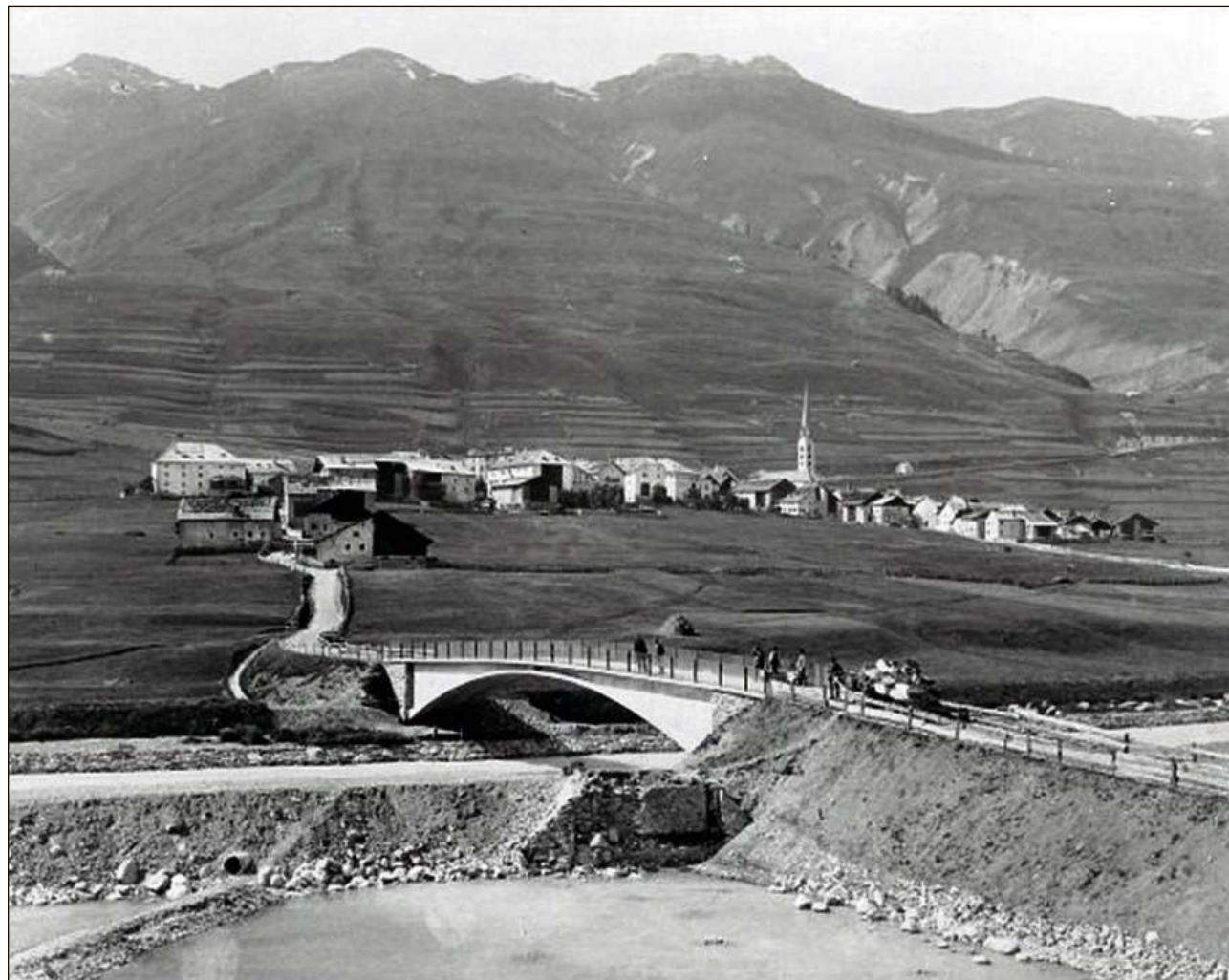
Tradiziun frunta sin moderna: Punt da l'En a Zuoz, construida l'onn 1901 da Robert Maillart.
