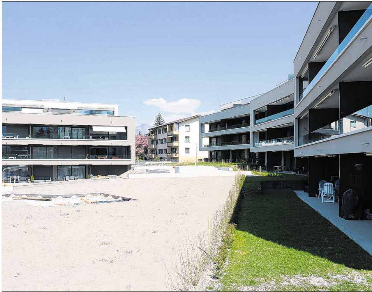
La cumpart da cumpras d'abitaziuns cun intents da caracter speculativ è, sco che la BCG constata, en Grischun survesaivla.
