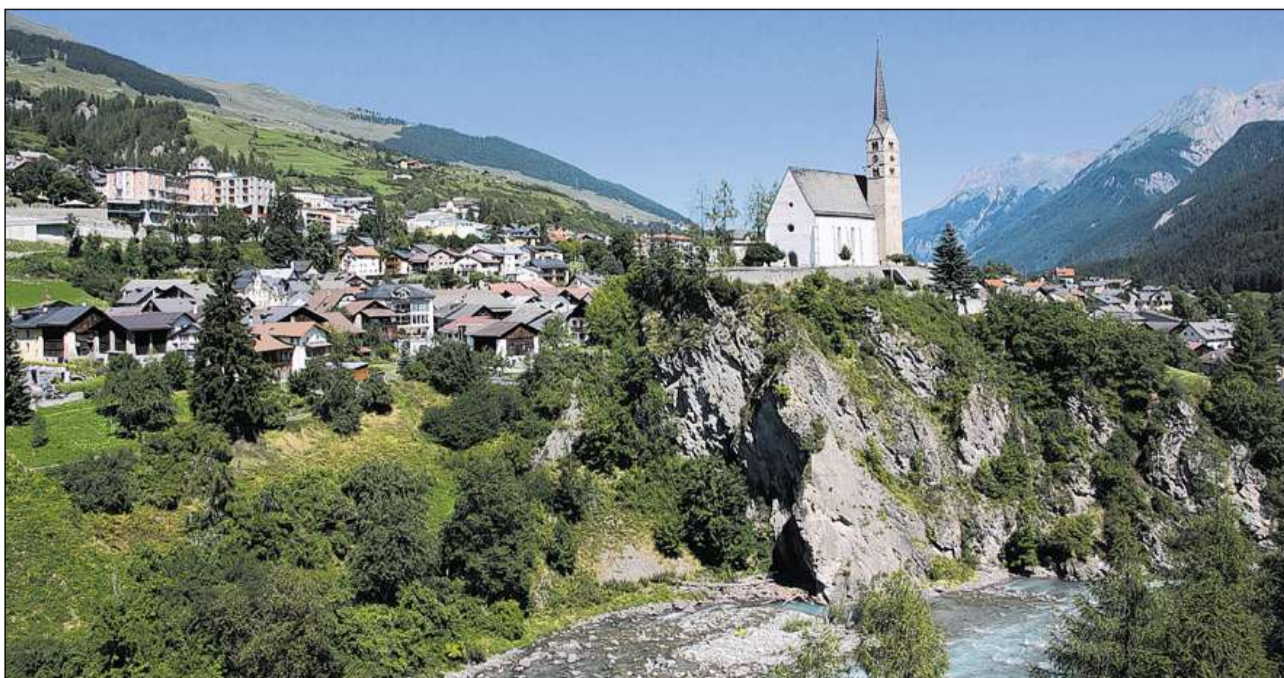
Scuol cun la baselgia reformada situada sur l'En.
