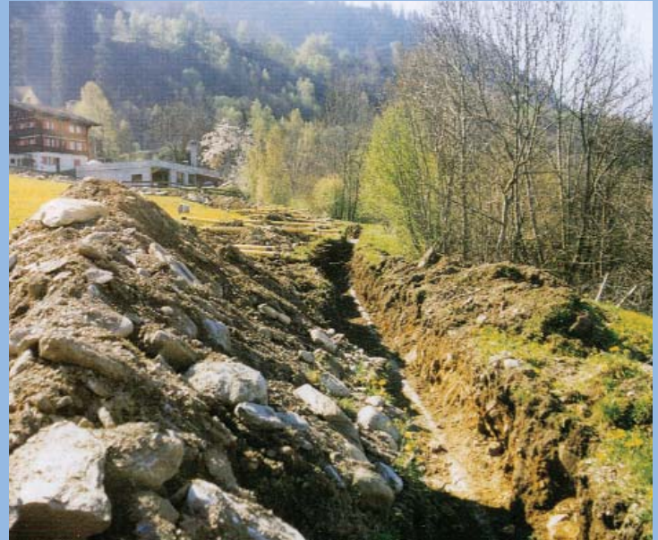
Ausbau der Wasserversorgung zur Sicherstellung von genügendem und qualitativ gutem Trinkwasser
