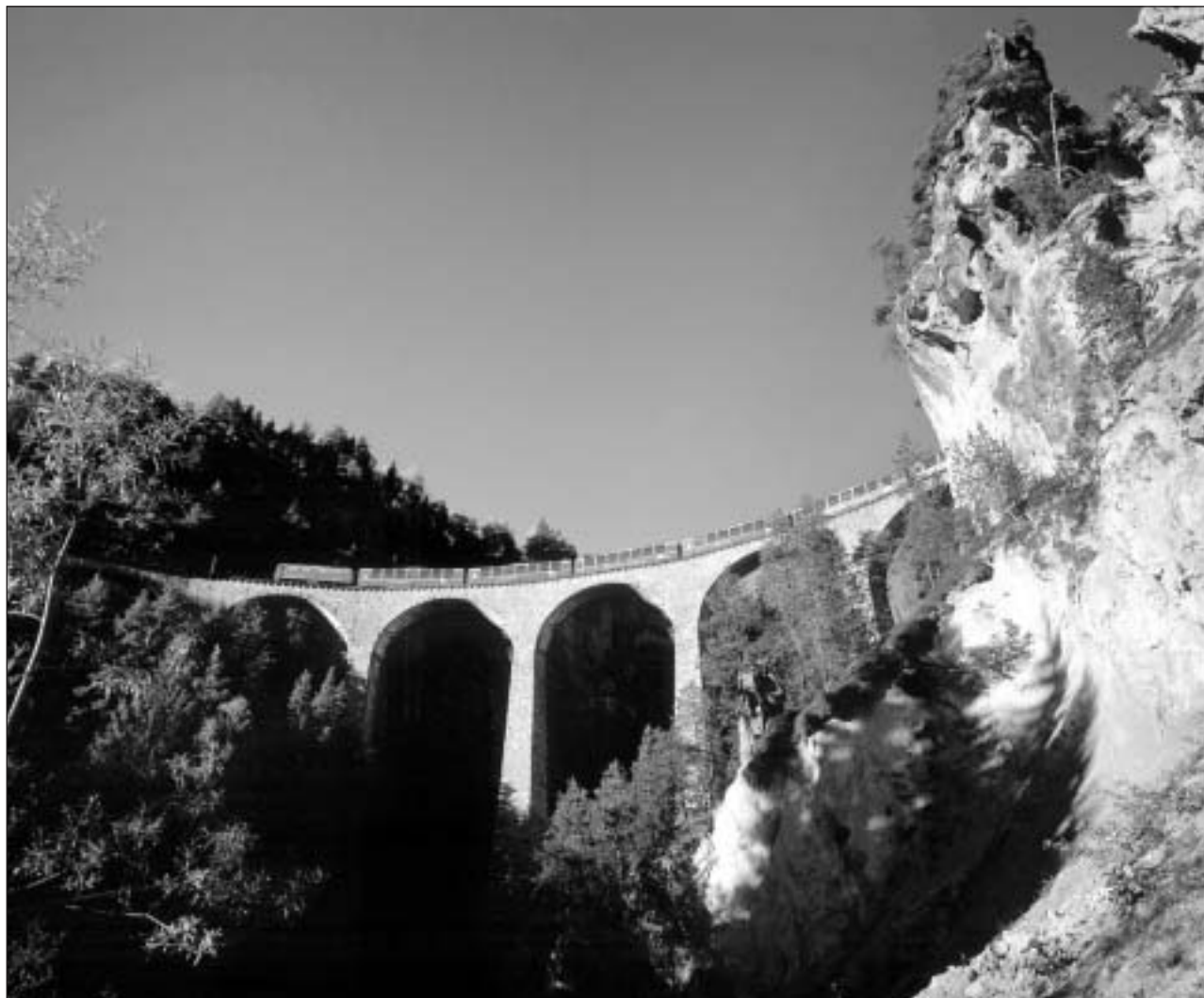
Il viaduct da Filisur na fascinescha betg mo ad amaters da viafiers.
